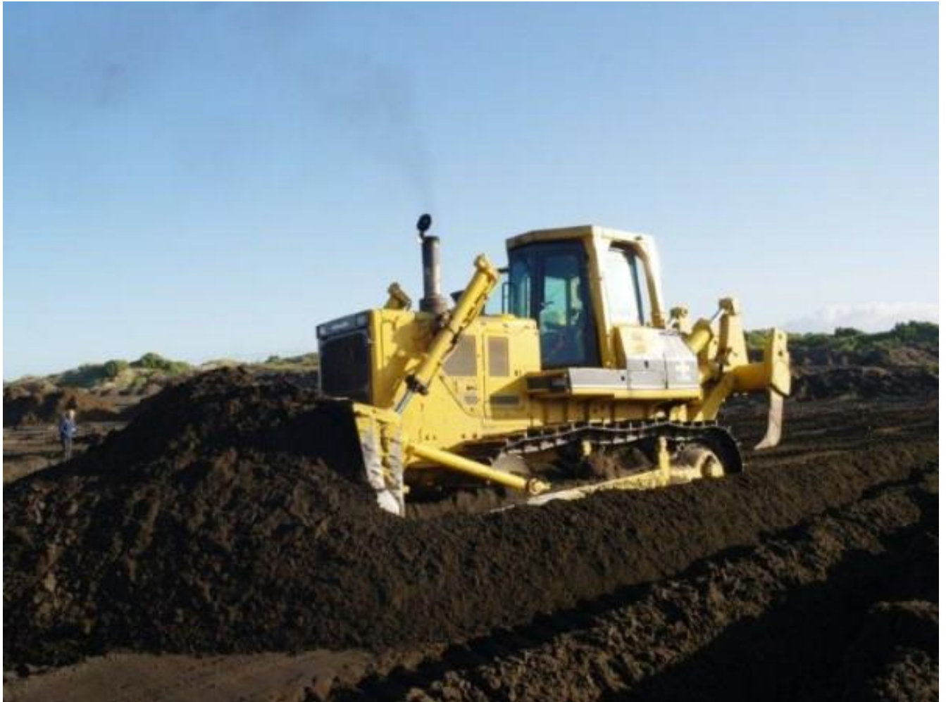
Рис. 2. 3. Процес зняття верхнього шару ґрунту при грубій рекультивації
