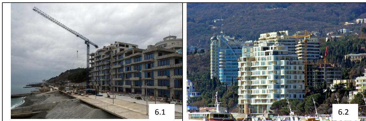
Рис. 6. Строительство в стометровой зоне
