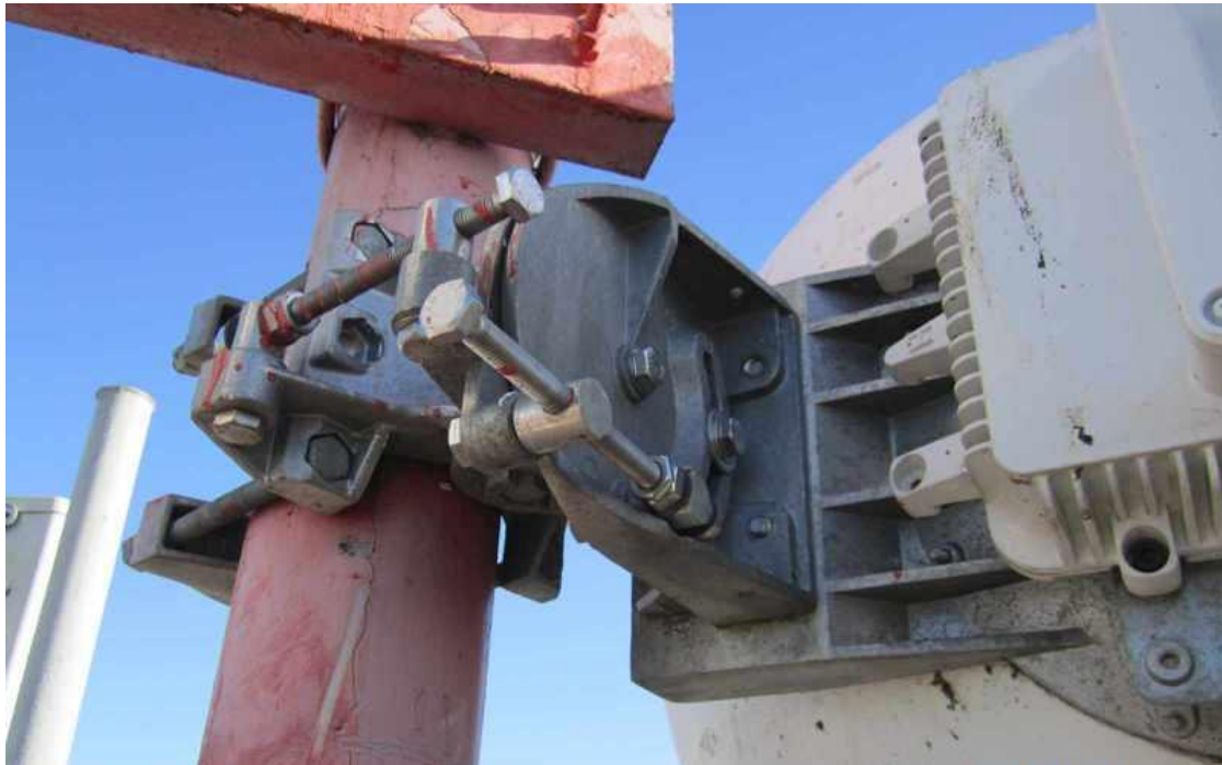
Рис.2.12. Варіант зручного кріплення РРС-антени
