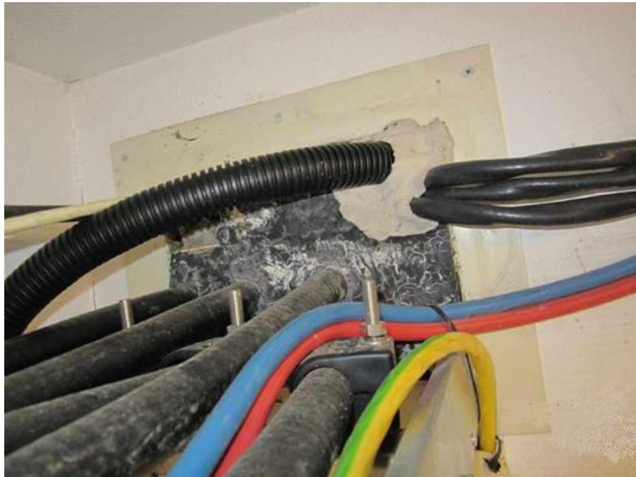
Рис.2.9. Герметична ізоляція від вологи
