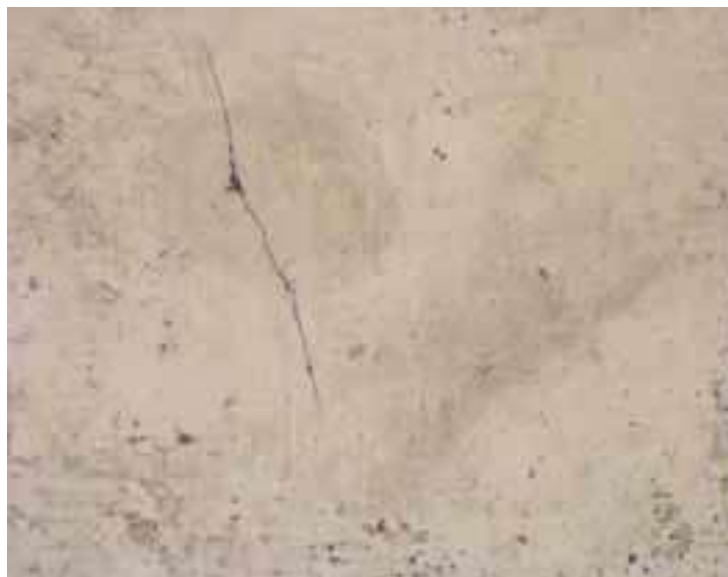
Рис. 2.3 Пошкодження від втоми
