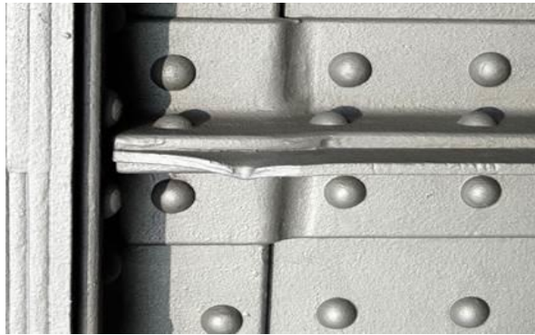
Рисунок 3.17 Заклепкове з'єднання
