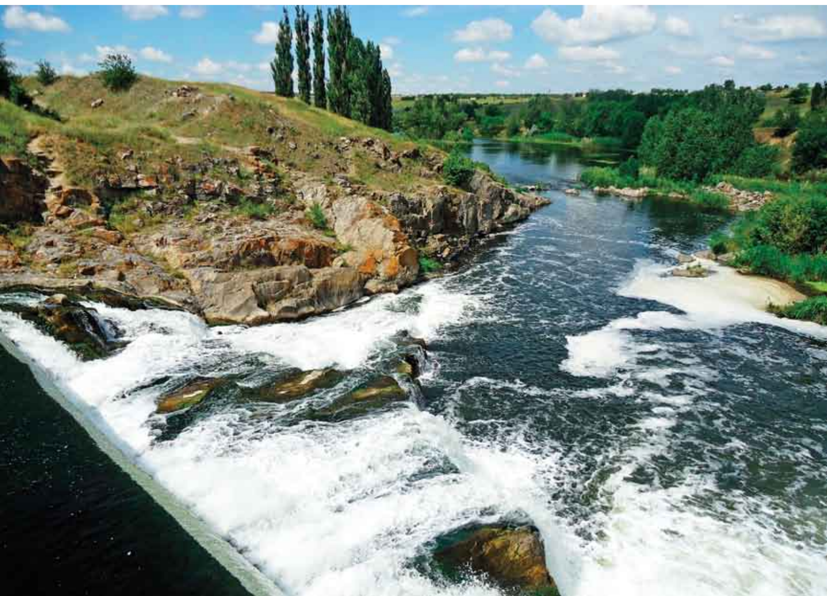
Нижній б'єф Софійського водосховища на р. Інгул | Tail-water of the Sofiyivske Reservoir on the Inhul River
