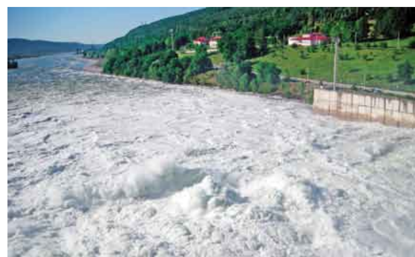
Нижній б'єф Дністровської ГЕС під час наводка Tail-water of the Dniester hydropower station during a flood
