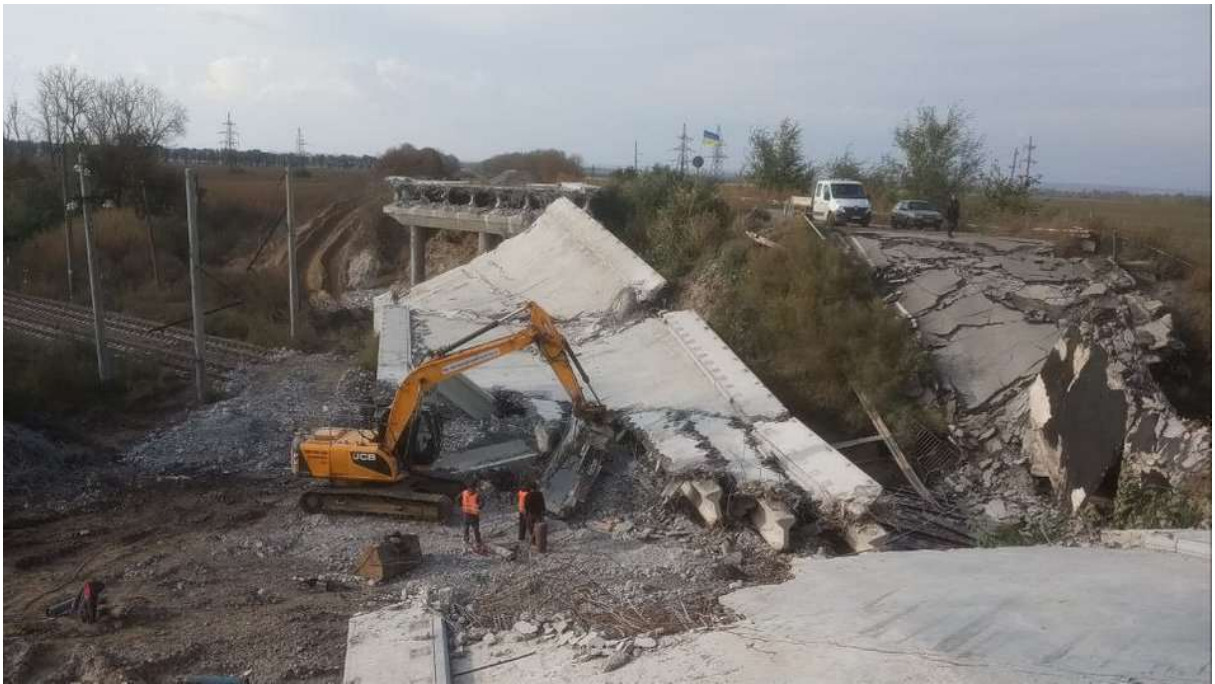
Рис. 1.1 Зруйновані мости Харківщини
