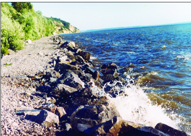
Ліворуч — укріплення берега накидом каменю біля смт. Градізък (Кременчуцьке в-ще); праворуч — біля с. Мар'янське (Каховське в-ще).
